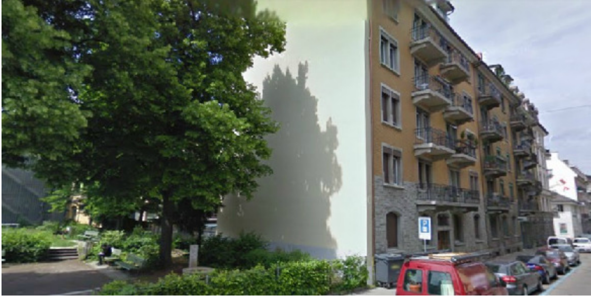
Brandmauer an Feldstrasse 39, 8004 Zürich
