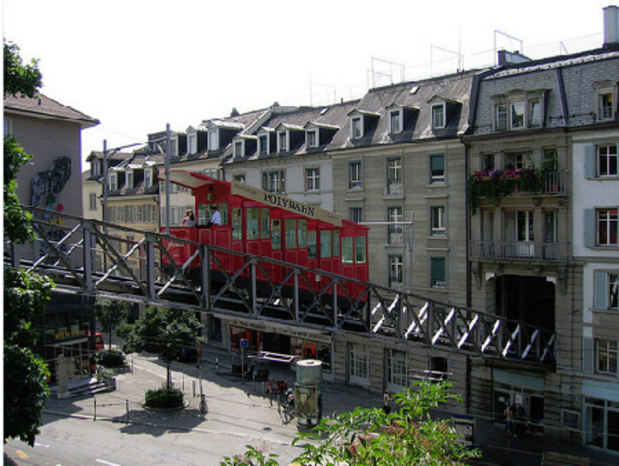
Polybahn-Brücke über den Seilergraben (Zürich)
