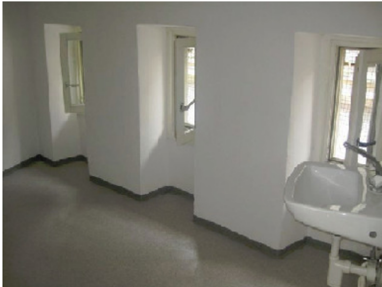
Nicht-funktionale Fensternischen, Zollstr. 14, 8005 Zürich
