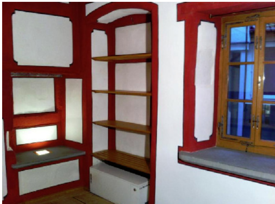
Nischen als Fensterbrett, Regal und Sitzbank, Storchengasse 17, 8001 Zürich (Mittelalter)
