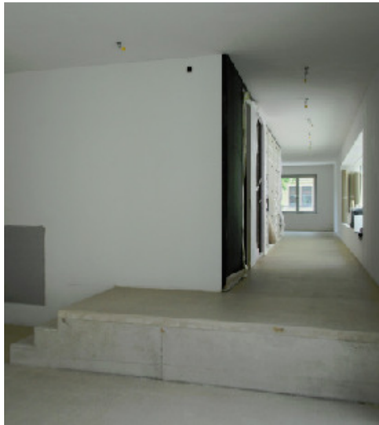
Treppe als Schwelle, Bolleystr. 35, 8006 Zürich
