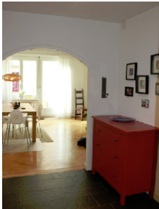
Zero-Schwelle mit verschiedenen Bodenbelägen, Wandeingassung und Rundbogen, Klosbachstr. 72, 8032 Zürich
