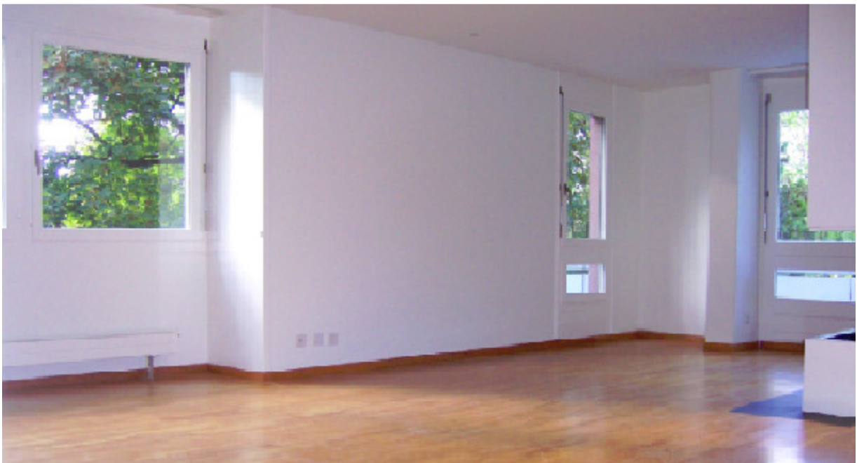
„Fehlende“ Fenstersimse, Doldertal 10, 8032 Zürich
