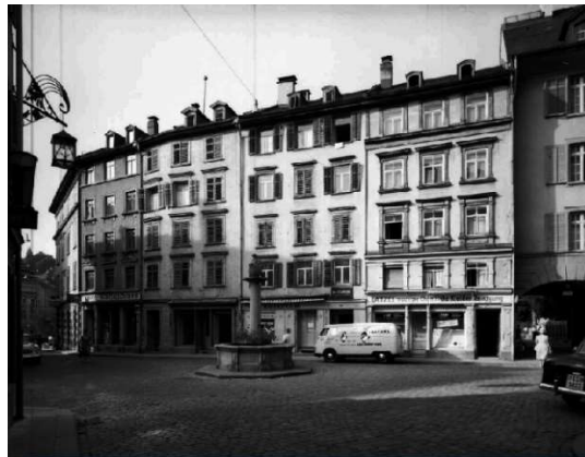
Ehem. Systeme Brühlgasse Nrn. 1, 3, 5, 7 und 9 vor Abbruch (1959)
