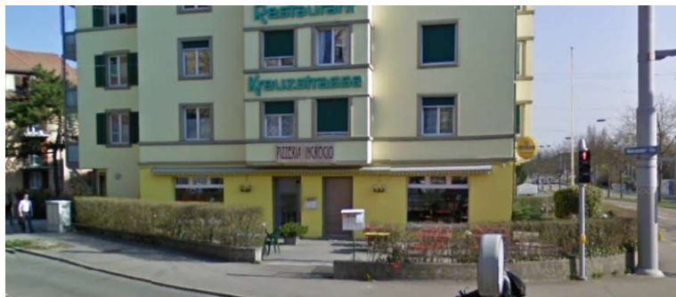
Pizzeria Incontro, Schaffhauserstr. 133, 8057 Zürich
