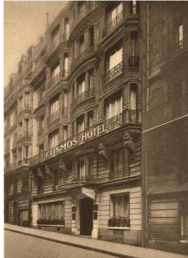
Ehem. Hôtel Cosmos, 14, rue Lentonnet, 75009 Paris (1934)
