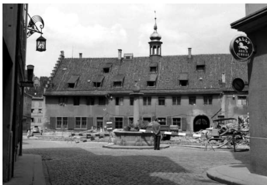
Kaufhausweg von Süden, nach Abbruch der Häuserzeile (1959)
