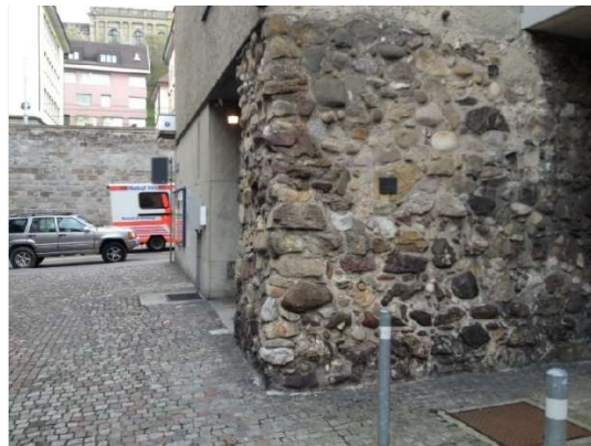
Rest der Stadtmauer, Seilergraben, 8001 Zürich
